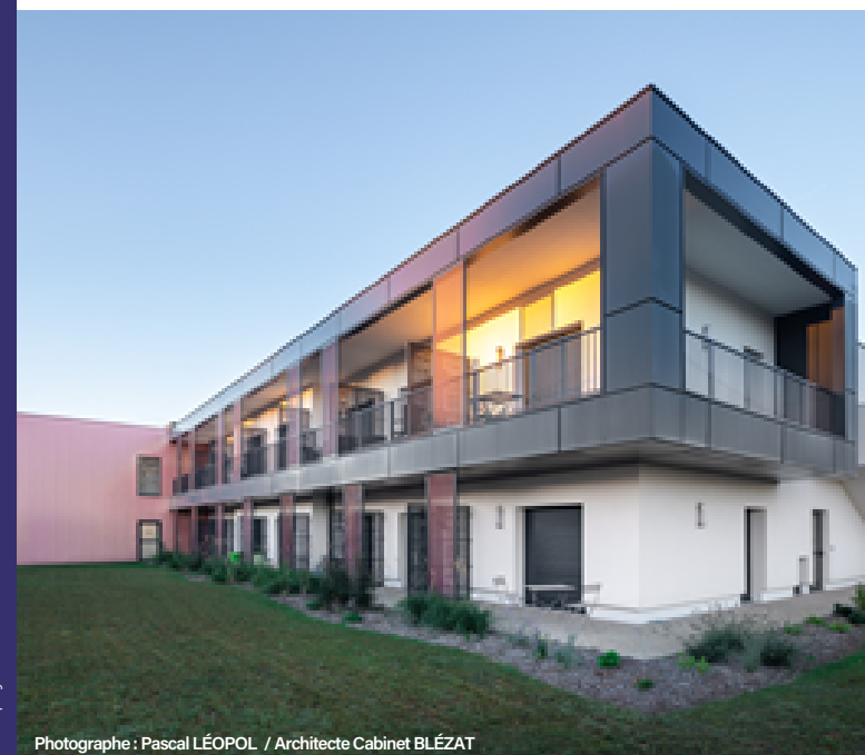
Photographe : Pascal LÉOPOL / Architecte Cabinet BLÉZAT
